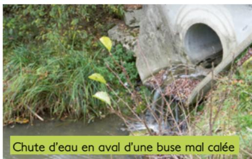
Chute d'eau en aval d'une buse mal calée
