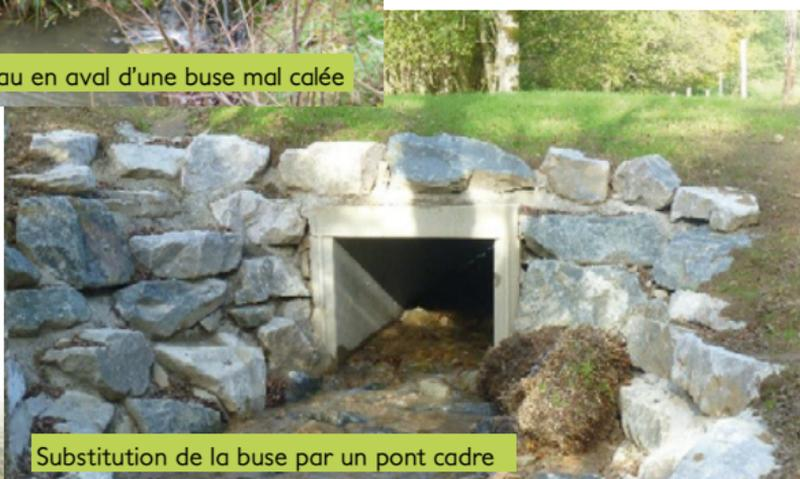
Substitution de la buse par un pont cadre
